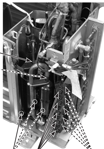
Écrous du compresseur
